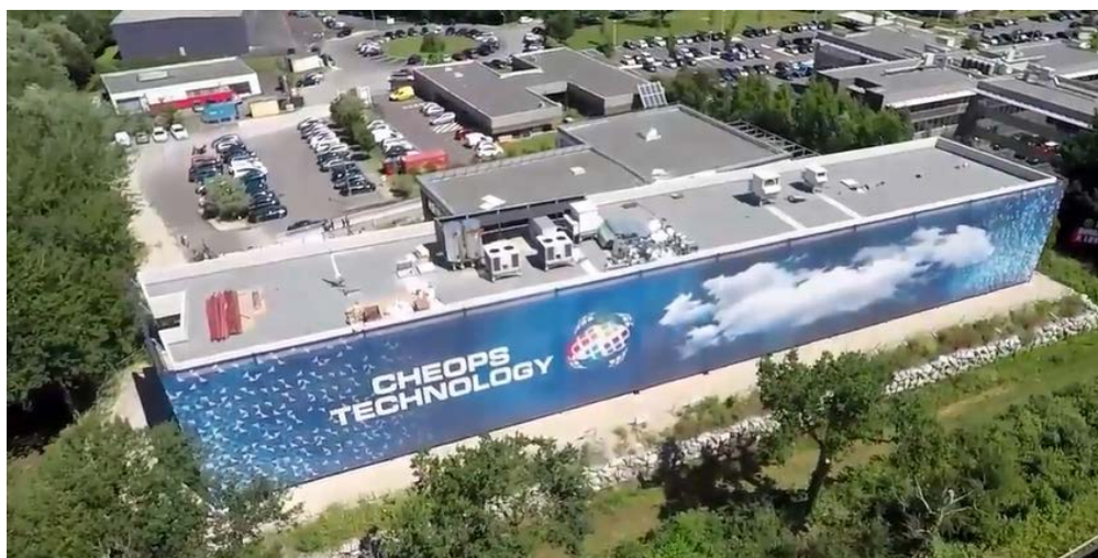
Le siège et le datacenter de Canejan, près de Bordeaux
